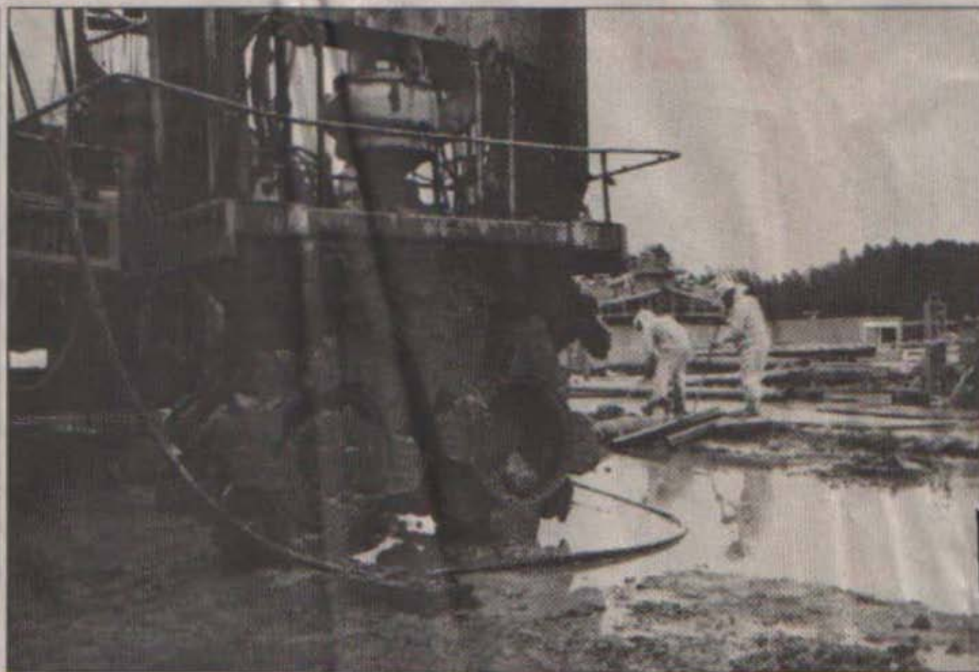
Arbeiten für das Testfeld zur späteren Einkapselung auf der Giftmülldeponie Münnehagen: Im Vordergrund der nach Herstellung einer Schlitzlamelle herausgezogene Fräskopf. Dahinter Beschäftigte des Baubetriebs. Foto: Bezirksregierung
